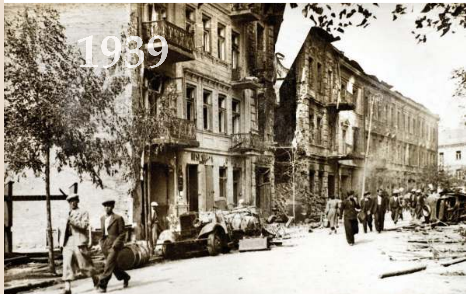
Zniszczone kamienice i samochody, ul. Kapucyńska w Lublinie; fot. L. Hartwig, wrzesień 1939 roku.
